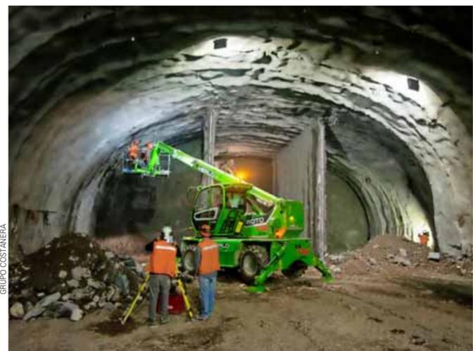
Los túneles mineros de AVO II avanzan en su ejecución con métodos constructivos como el Austriaco y el de Túnel Híbrido, este último para la conexión expresa con AVO I.
